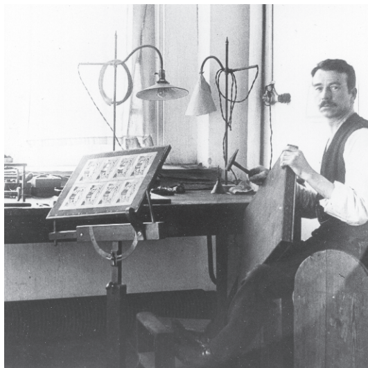
Jens Bomholt fotograferede sig selv i en typisk arbejdsposition som formbinder i gang med en form og med et form-stativ til venstre. Fra omkring 1910.
