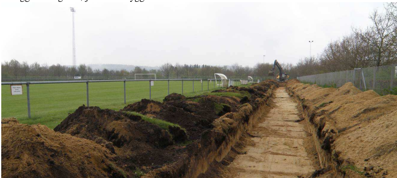
Søgegrøft vest for bane øst, matr. nr. 17ag. Nordlig del af bane øst er afgravet og dozet ned på sydlige del af banen. Maj 2012
