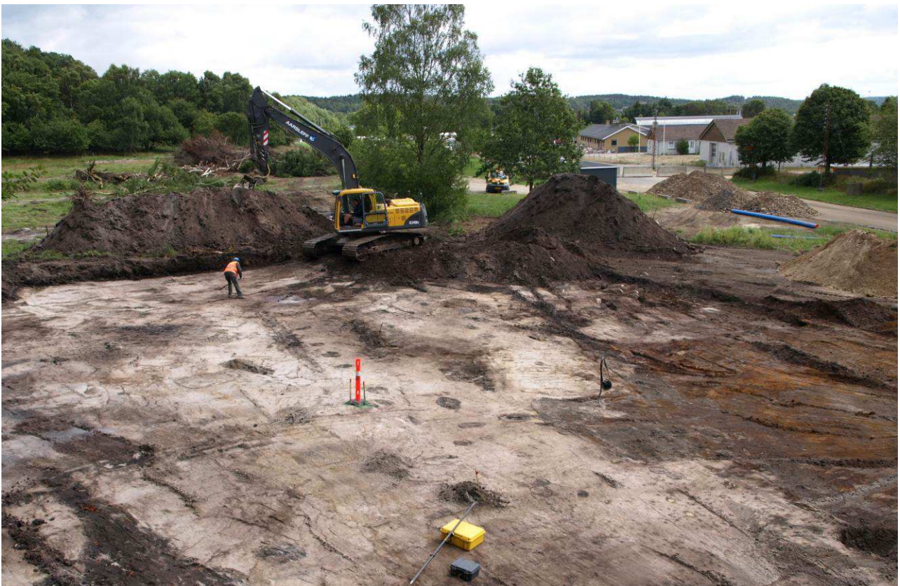
Middelalderhuset ved afrømning med maskine, august 2012. Bemærk rækken af stolpehuller mellem maskinen og den orange markeringspæl.
