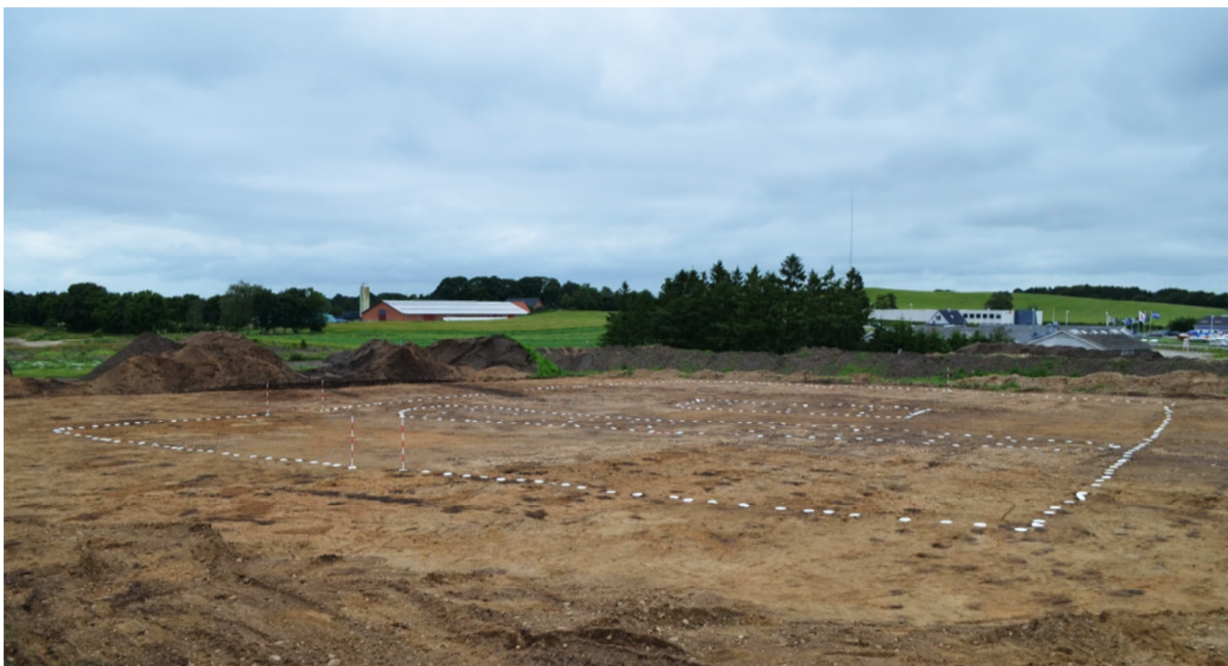
En hel tofte, langhus og økonomibygninger med omgivende hegn markeret med paptallerkener. Tre porte i hegnet markeret med landmålerstokke.
