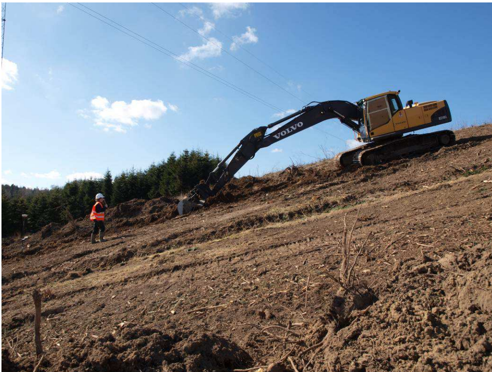
Mod vest stiger terrænet nogle steder så meget, at det var en udfordring for gravemaskinen.
